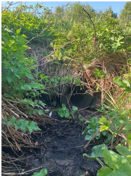
Figur 12. Dikesbotten uppströms trumma, under kraftledningsgata.
