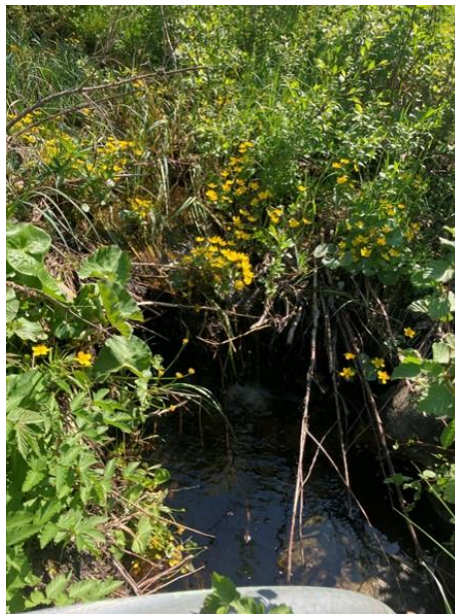
Figur 20. Stalp uppströms trumma vid skogsbilväg.
